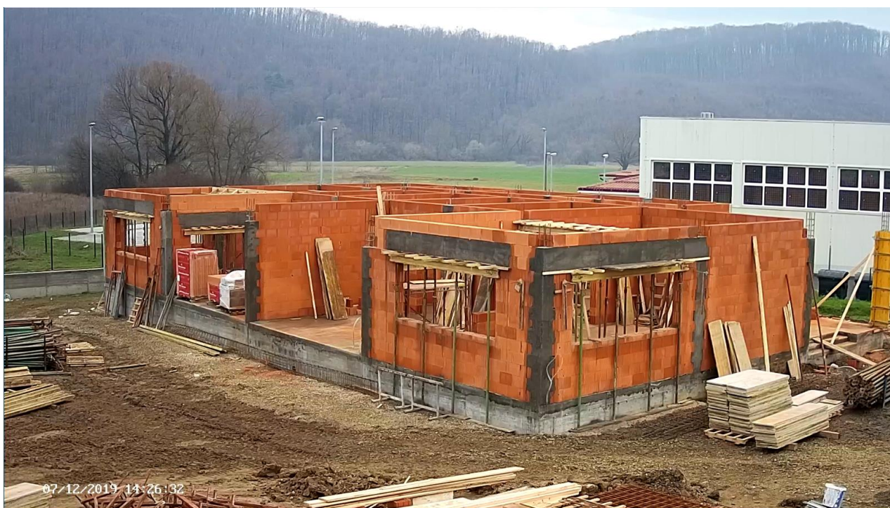
Slika 10: Snimka praćenja radova: završen prvi kat na dan 07.12.2019.
