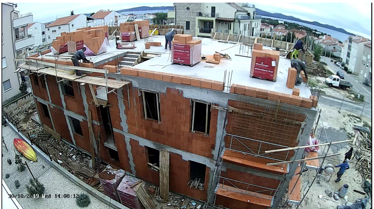
Slika 5: Snimka praćenja radova: završen prvi kat na dan 30.10.2019.
