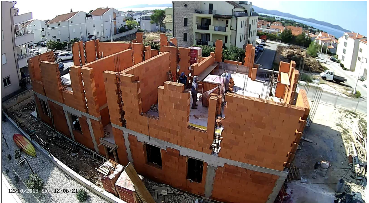
Slika 4: Snimka praćenja gradilišta na dan 12.10.2019.
