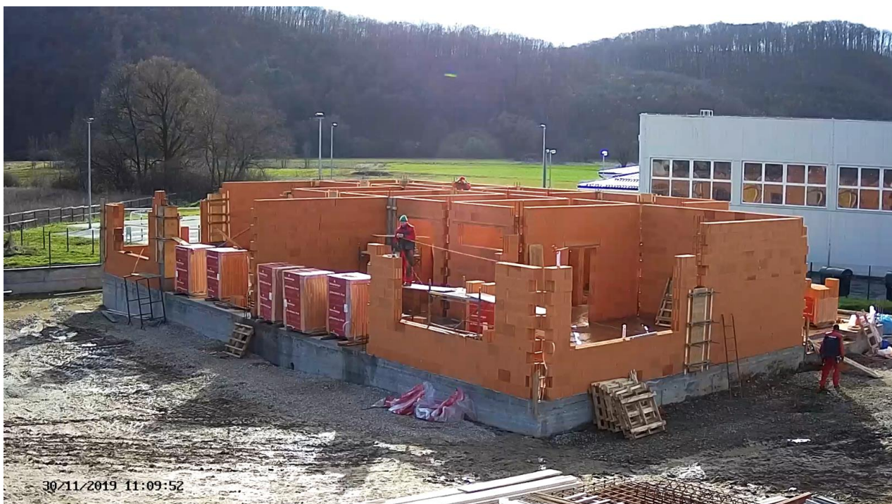
Slika 9: Snimka praćenja gradilišta na dan 30.11.2019.
