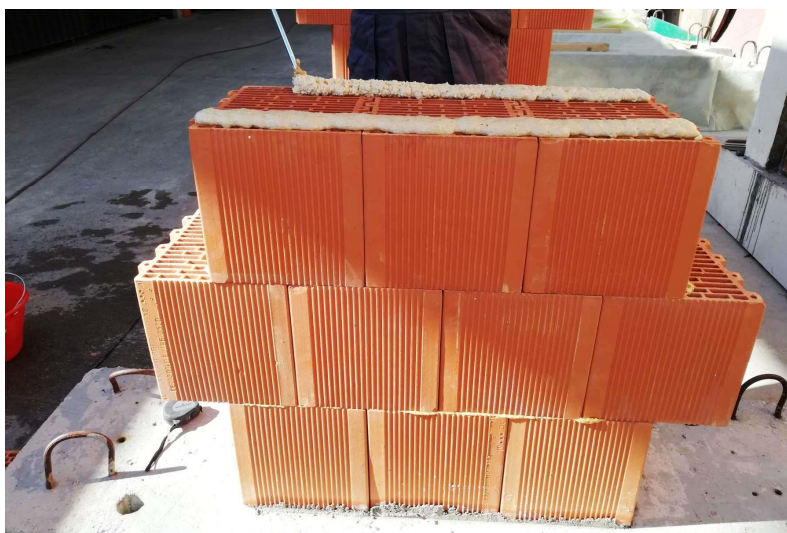
Slika A2: Nanos PU lepila na tretjo vrsto zidakov.
