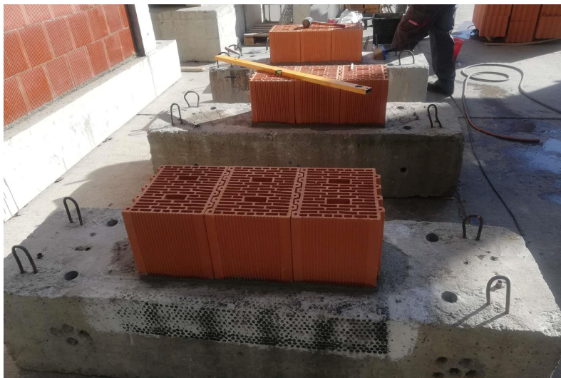
Slika A1: Priprava preizkušancev za tlal'ni preskus - zidanje prve vrste zidakov na izravnavo iz cementne malte.
