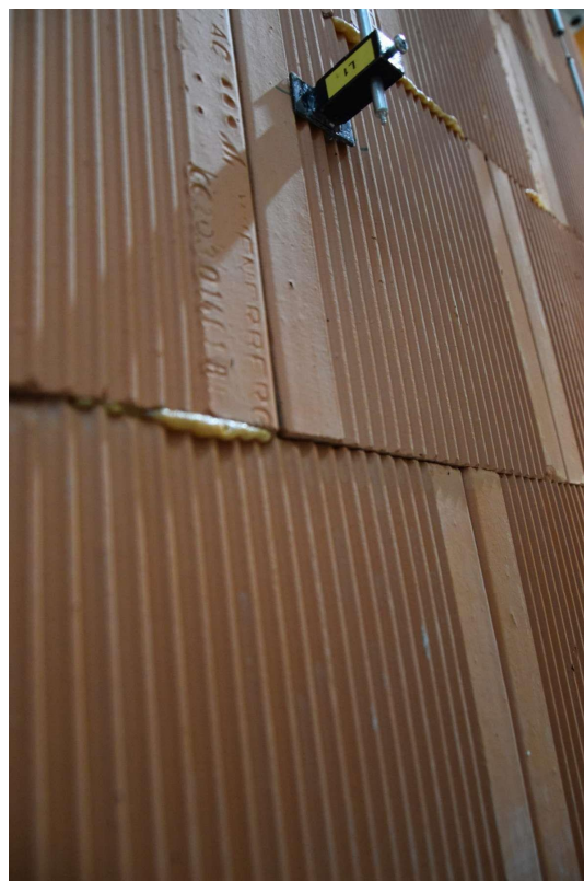
Slika A5: Tlorisni zamik druge vrste zidakov glede na prvo vrsto znaša 2,98 mm, kar znaša 30,8 % debeline stene zidaka.
