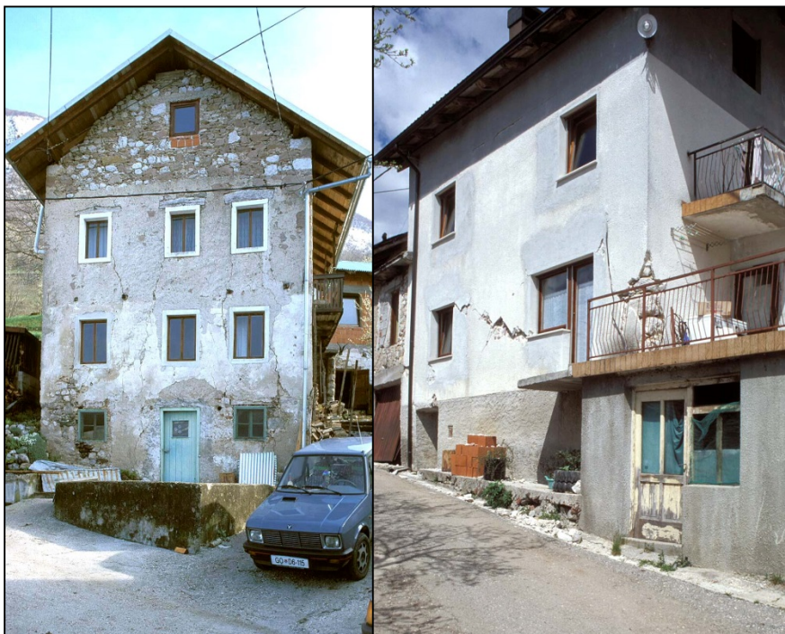
Po potresu leta 1998 poškodovane Drežniške Ravne
