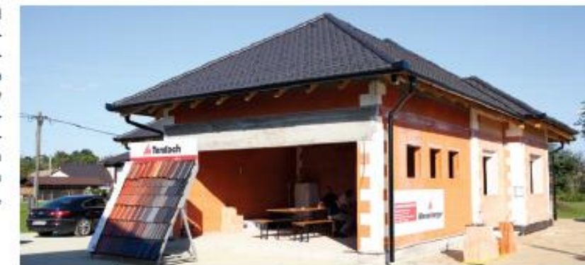
Novogradnja v Črenšovcih - energetska učinkovita hiša z izdelki in materiali podjetja Wienerberger.
